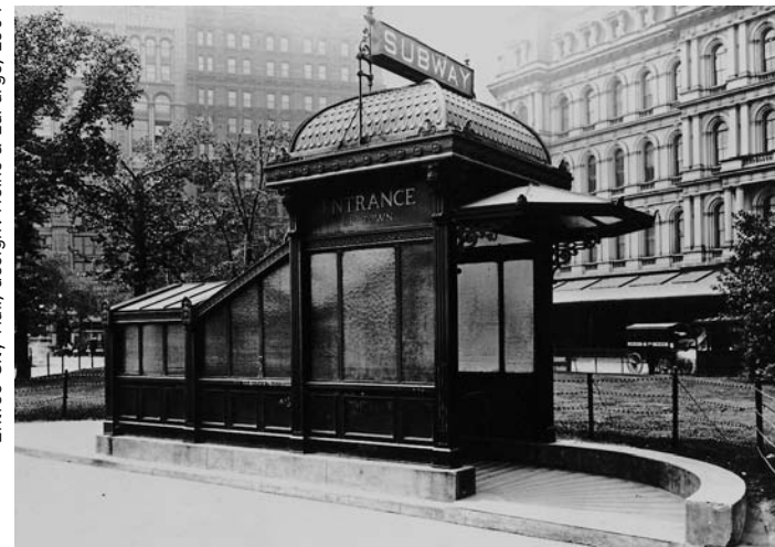
Entrée City Hall, design : Heins & LaFarge, 1904
